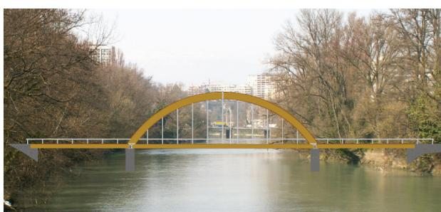
La deuxième variante a été élaborée en privilégiant l'aspect esthétique de l'ouvrage. L'idée est basée sur un concept d'une fine ligne à l'horizon avec un arc de faible hauteur pour marquer le centre du pont.
