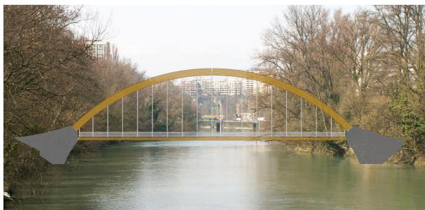
La première variante est basée sur un concept de simplicité. Elle se compose de deux arcs à trois articulations et d'un tablier comprenant des sommiers avec un système de contre ventement en treillis horizontal, les solives qui sont comprises dans le treillis reprennent l'ensemble du revêtement en deux couches supports en panneaux stratifiés avec un revêtement bitumineux.
