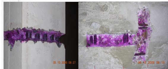
Sondage sur sommier au rez-de-chaussée bâtiment 1 Sondage sur dalle au sous-sol bâtiment 3 (Contrôle des armatures et profondeur de carbonatation)
