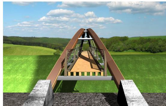
Cette structure est constituée de deux arcs inclinés sur l'intérieur reposant sur des massifs en béton armé, prenant appui sur des micropieux.
