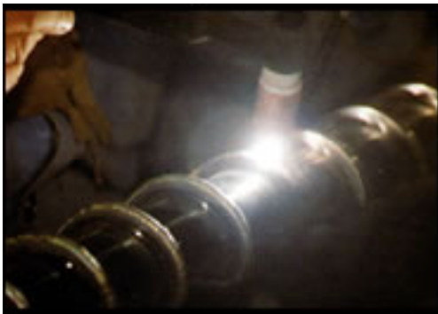
Dépôt de Stellite® par procédé TIG sur une vis d'extrudeuse
