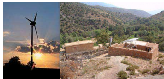
Figure 2 : Installations éolienne et photovoltaïque
