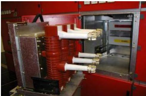
Fig 1 – Disjoncteur shunt du réseau de Baden
