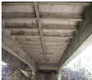
Structure des trois ouvrages
