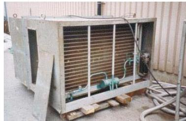
Groupe frigorifique utilisé pour déshumidifier l'air introduit dans la conduite forcée.
